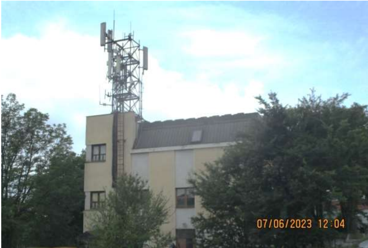
Slika 2.4 Objekat na kome je montirana predmetna BS
