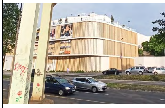
Lokacija buduće bazne stanice
