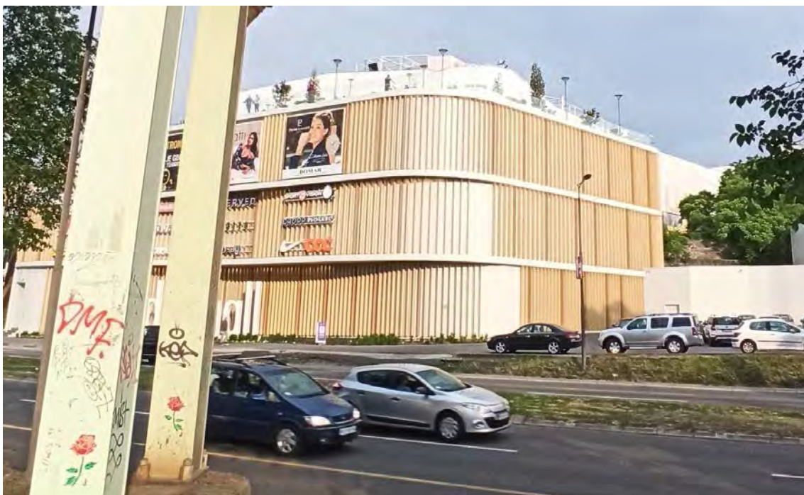
Slika 3.1 – Izgled lokacije na kojoj se planira instalacija bazne stanice
