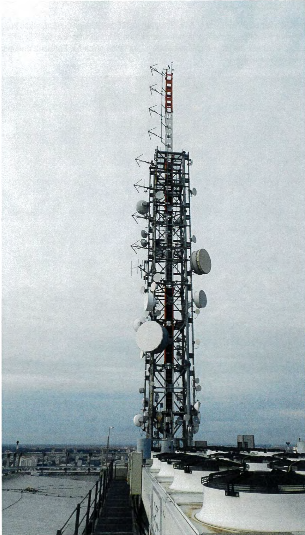
Slika 3: Prikaz antenskog stuba na kom se nalazi FM radio stanica
