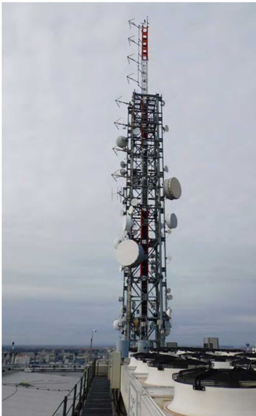
Slika 2.4 Fotografija antenskog stuba kojem se nalazi predmetna radio stanica
