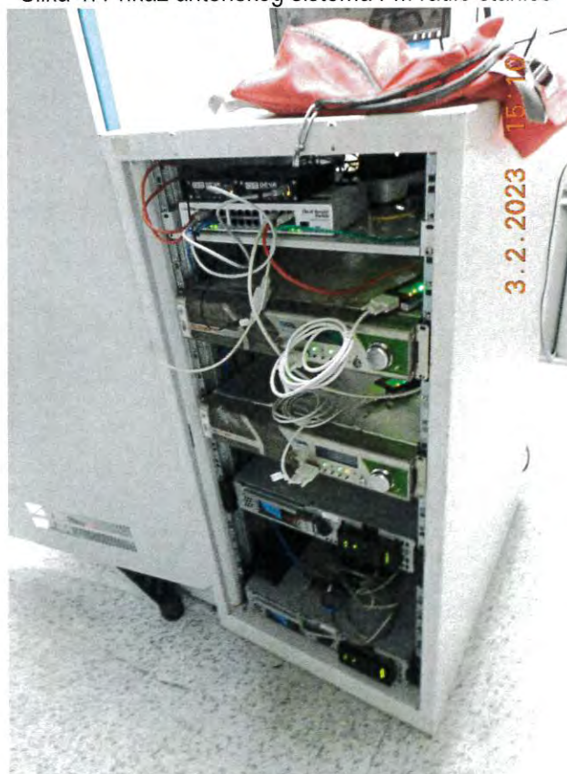
Slika 5: Prikaz indoor emisione opreme (FM predajnika)
