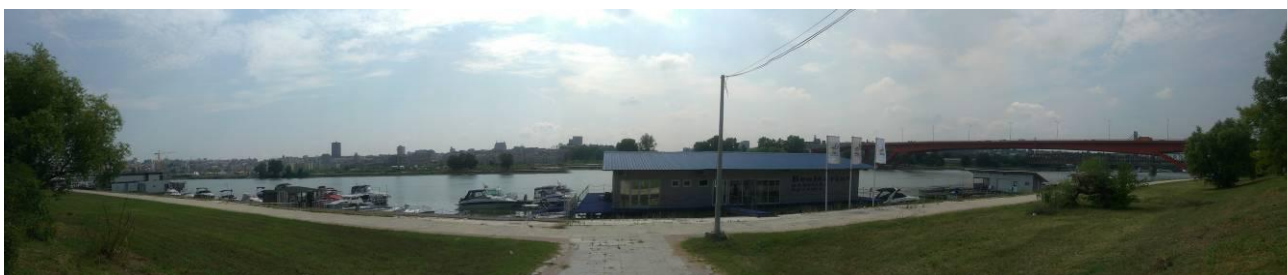
Слика 24: Простор реке Саве
