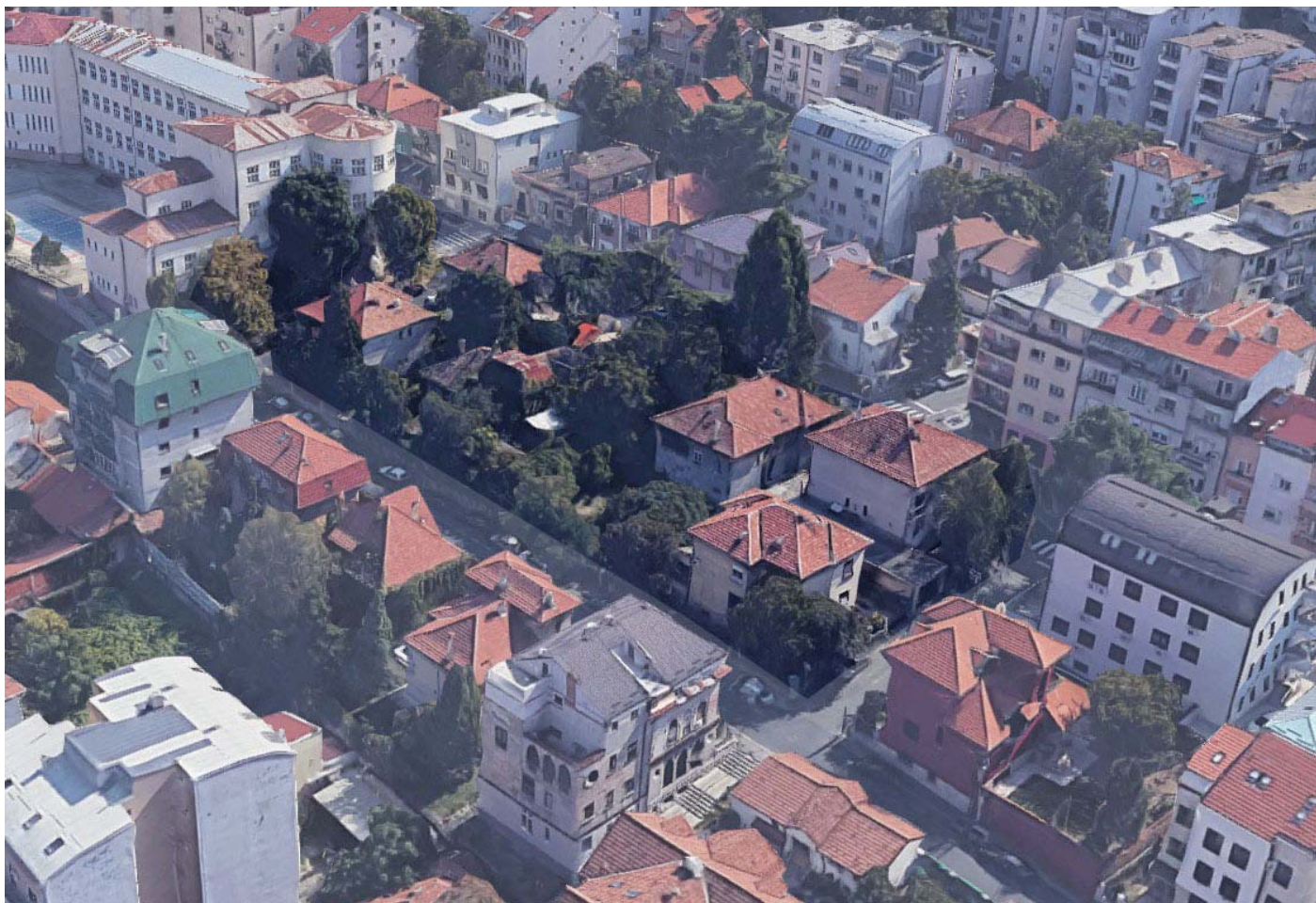
Слика 5 - поглед са северозападне стране
