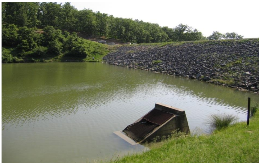
Слика 9. Бочни прелив на акумулацији Бела река
