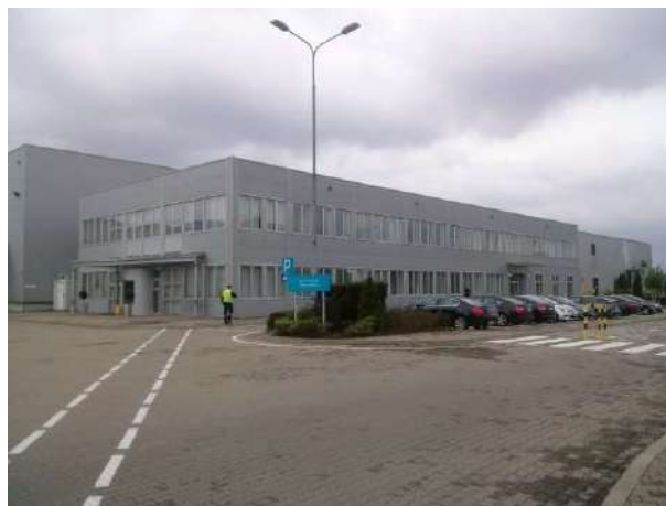
Slika 13. Proizvodnja sa administracijom i tehničkim blokom
