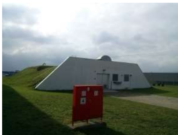
Slika 3. Sprinkler pumpna stanica sa rezervoarom vode
