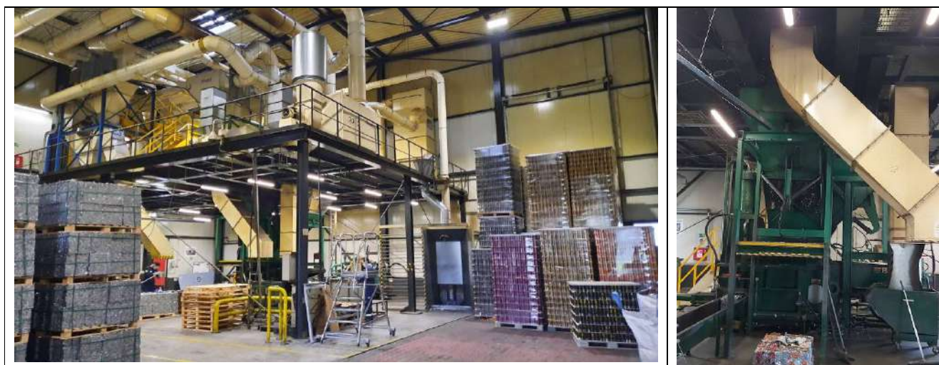
Slika 4. Izgled prese u predmetnom skladištu
