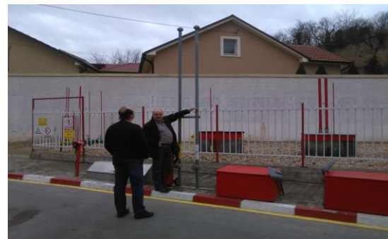
Slika 2.3. Odušne cevi rezervoara i protivpožarni zid
