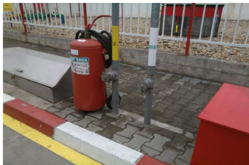
Slika 2.3. Odušne cevi rezervoara i protivpožarni zid
