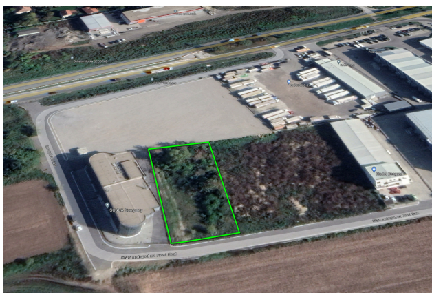
Постојеће стање блока - позиција ГП-1.
