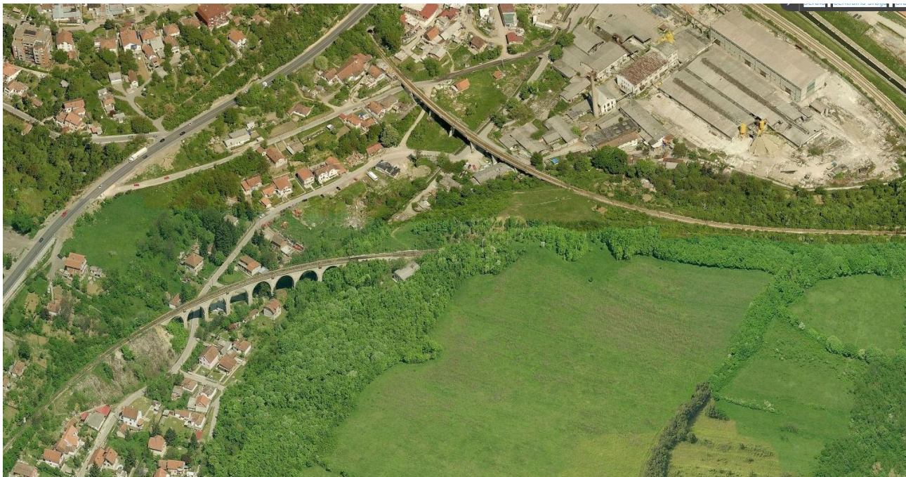
Слика 4. Деонице железничке пруге у обухвату Плана и источно од границе Плана
