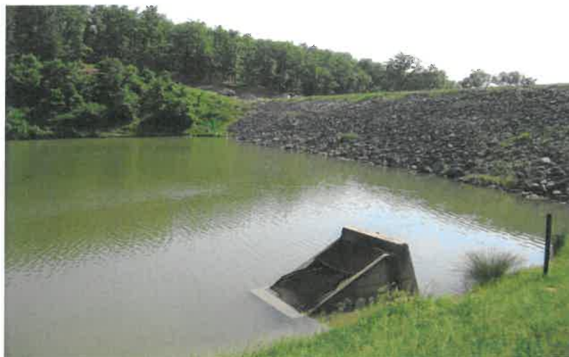
Слика 9. Бочни прелив на акумулацији Бела река
