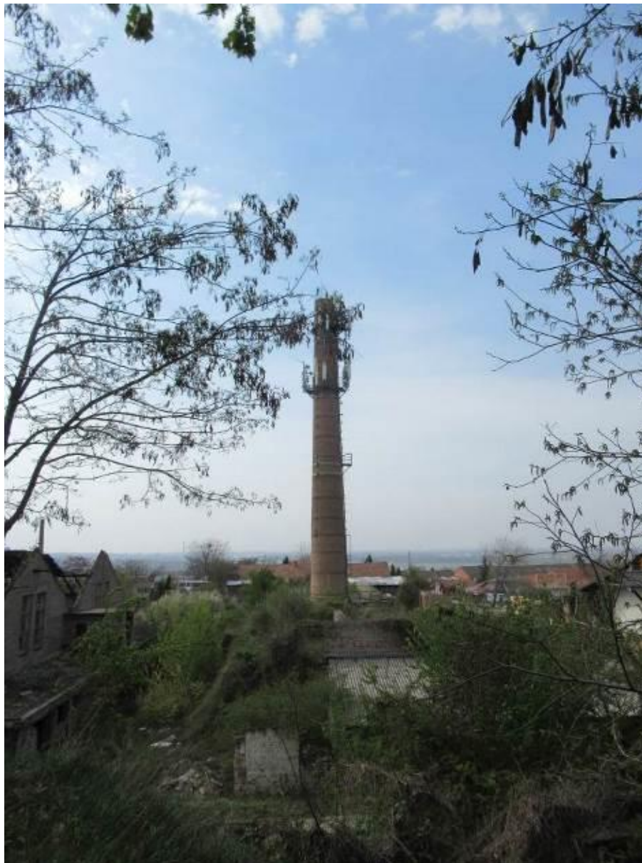
Slika 3.1.1. Fotografija objekta predmetne bazne stanice
