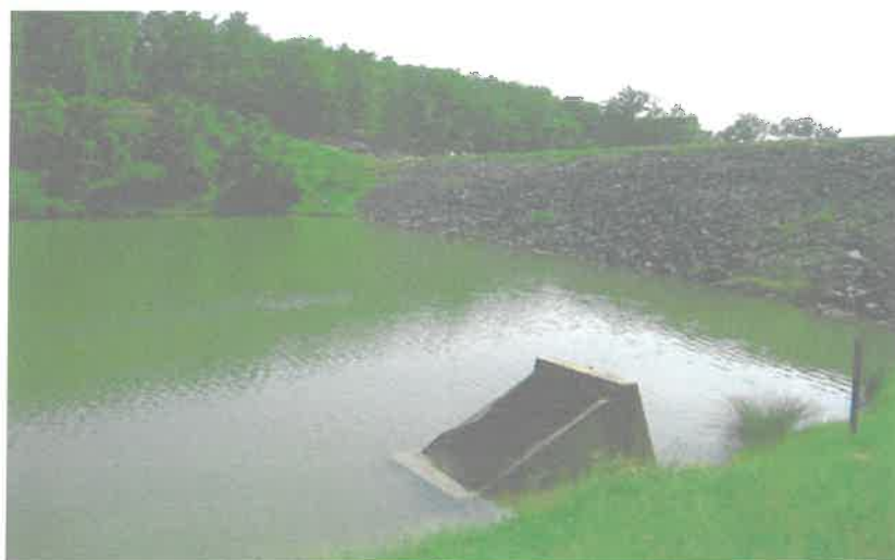
Слика 9. Бочни прелив на акумулацији Бела река
