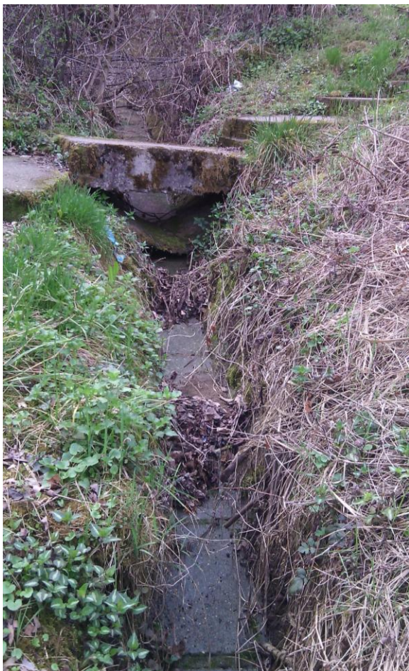
Слика 15: регулисани део Кијевског потока са бетонским прелазом
