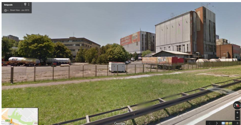
Слика 21: Поглед на комплекс БИП-а са аутопута
