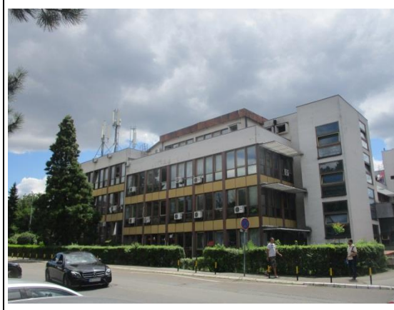
Lokacija bazne stanice
