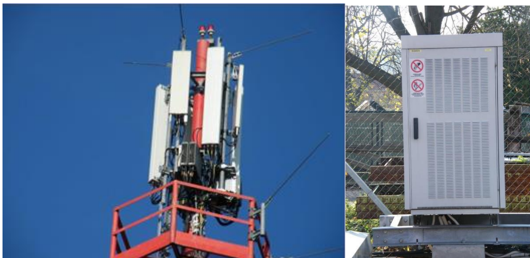
Slika 2.2.. Fotografije antenskog sistema i kabineta Radio Bazne Stanice (RBS) predmetnog izvora zračenja operatera A1 Srbija na lokaciji
