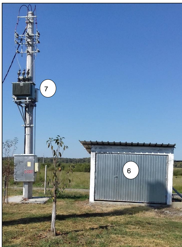
Слика 14. – Објект у којем је смештен агрегат (6) и Стубни трафо (7)
