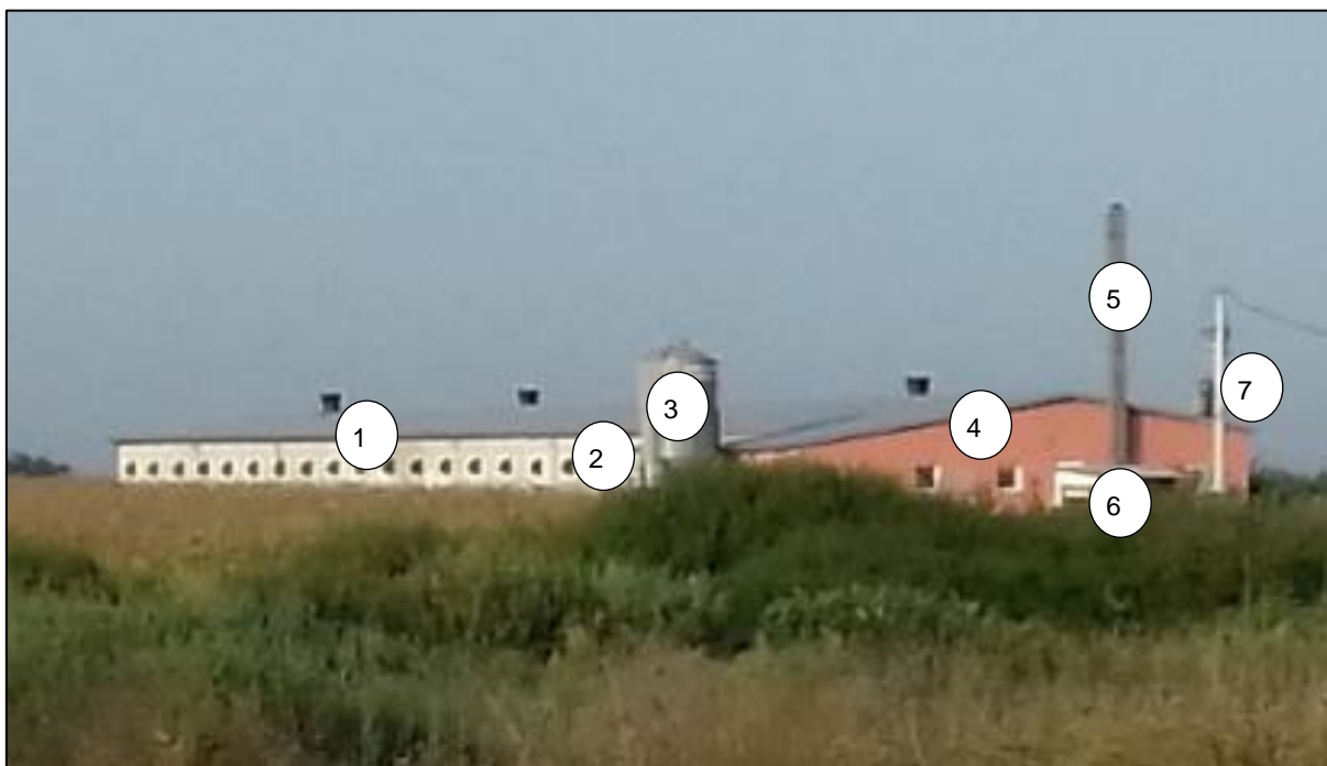
Слика 10. – Постојећи објекти за држање родитељског јата: стаја (1), расхладно саће (2), силос за храну (3), предпростор (4), димњак котла на чврсто гориво (5), агрегат (6) стубни трафо (7)
