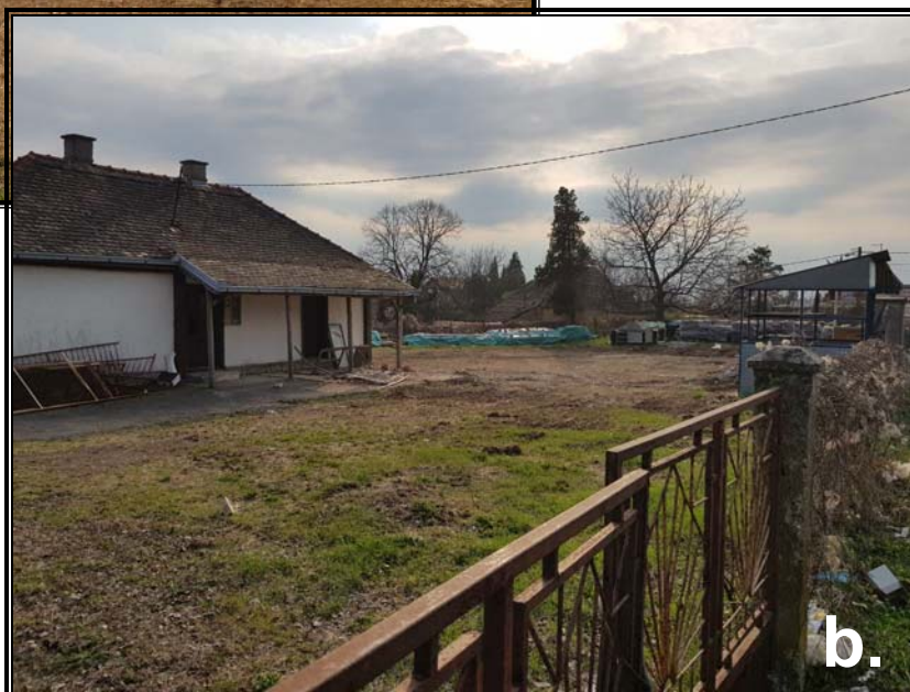
Slika br. 2 a, b Sadašnji izgled istražnog prostora predviđenog za izgradnju objekta stanice za snadbevanje gorivom
