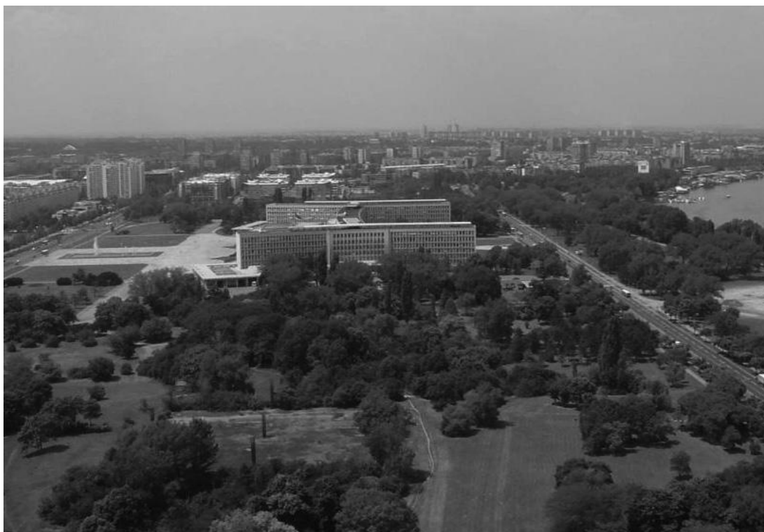
Слика бр. 4: Фотографија напуштених темеља Музеја на локацији Пројекта
