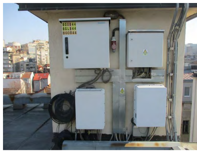
UOČENI IZVOR – Telekom RBS oprema (BEOGRAD,KARAĐORĐEVA 65)
