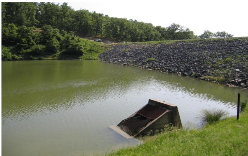
Слика 9. Бочни прелив на акумулацији Бела река
